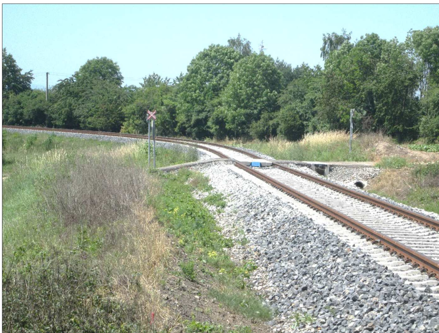
Zrekonstruovaná železniční trať a propustky pod polní cestou C5
